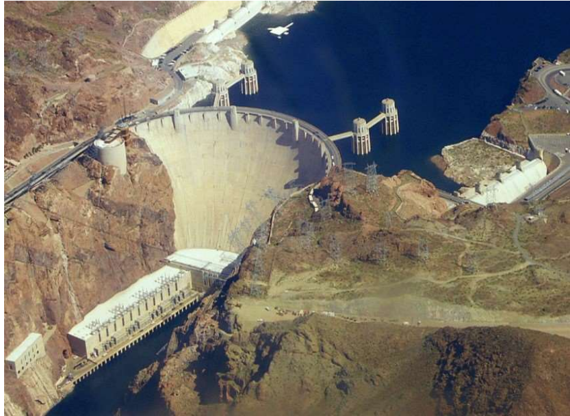
Figura 8 – Barragem de concreto em arco. Fonte: Possan (2015).
