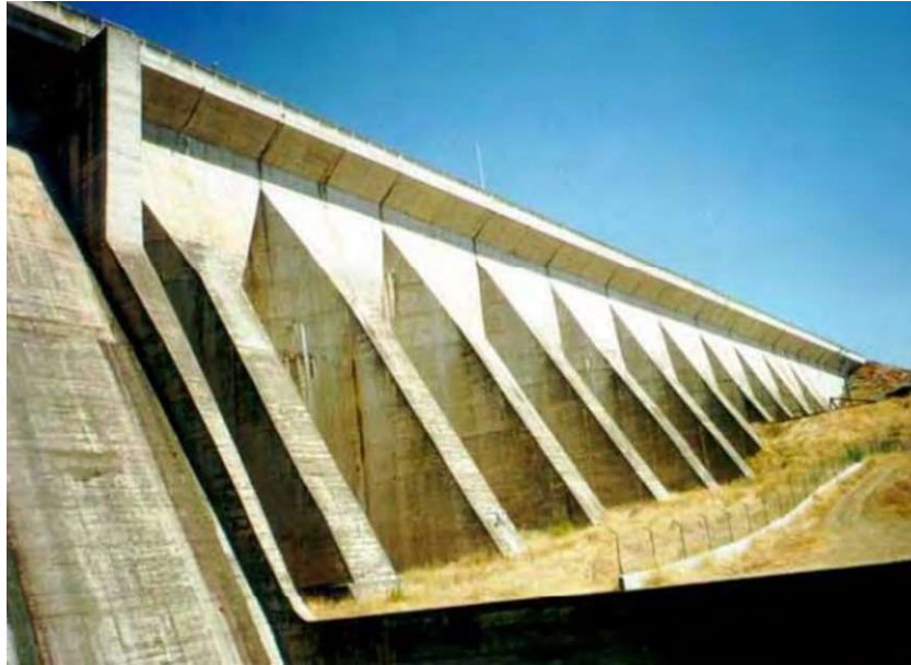
Figura 3 – Barragem de contraforte. Fonte: Ferreira (2007).
