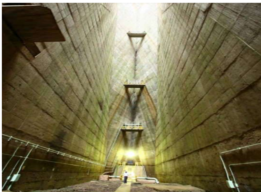
Figura 7 – Barragem de gravidade aliviada. Fonte: Moura (2016).
