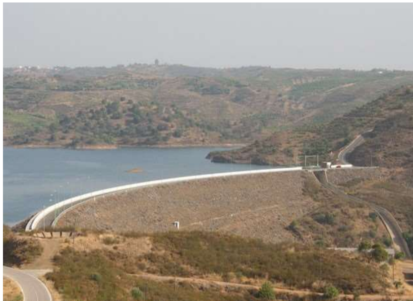
Figura 4 – Barragem de aterro de terra com seção homogênea. Fonte: Monteiro (2018).
