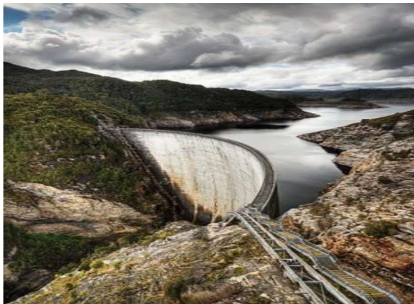
Figura 2 – Barragem em arco. Fonte: Souza (2013).
