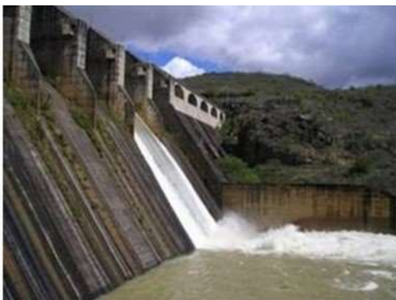
Figura 5 – Barragem de concreto estrutural com contrafortes. Fonte: Júnior (2016).
