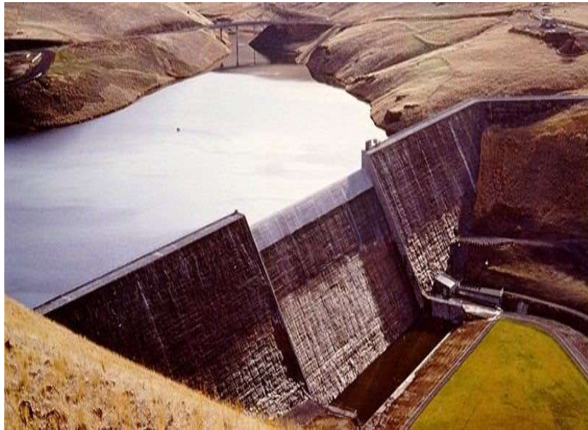
Figura 6 – Barragem de gravidade. Fonte: Moura (2016).
